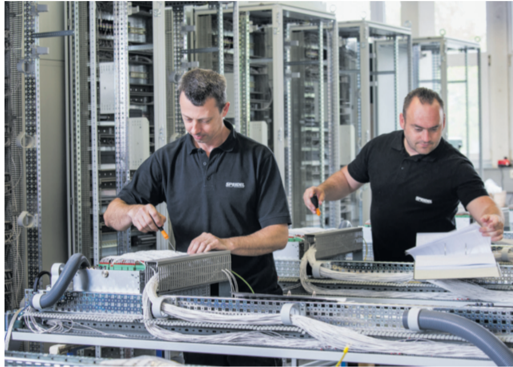
Die Abteilung wächst. Der Schaltschrankbau 4.0 wird immer mehr zum Thema.
