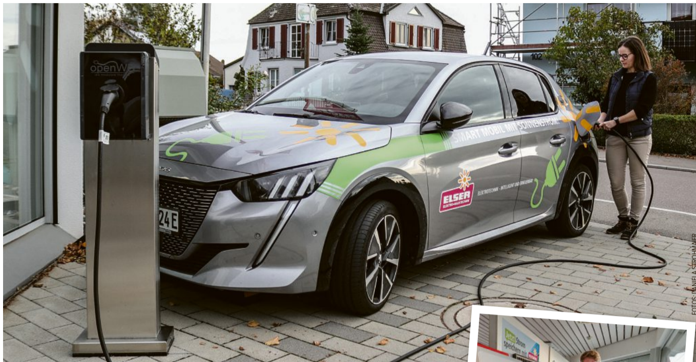
Das Auto mit selbsterzeugtem Strom laden – bei Bedarf auch nachts: Batteriespeicher und hybrider Wechselrichter machen es möglich. Rechts: Simon Löw und Annika Mühleisen von Elser Elektro + Haustechnik
