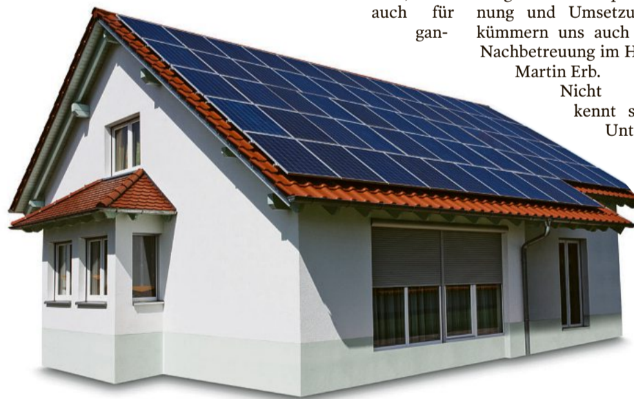
2023 hat die Elektro Erb GmbH mehr als 2000 PV-Module allein auf privaten Wohnhäusern installiert – dazu kommen zahlreiche Gewerbeanlagen. Foto: stock.adobe.com/trudidesign
